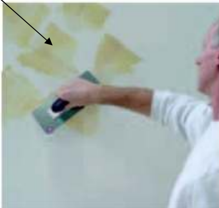
При полагането върху основата материалите се смесват посредством движението на шпаклара и създават ефектното покритие.
