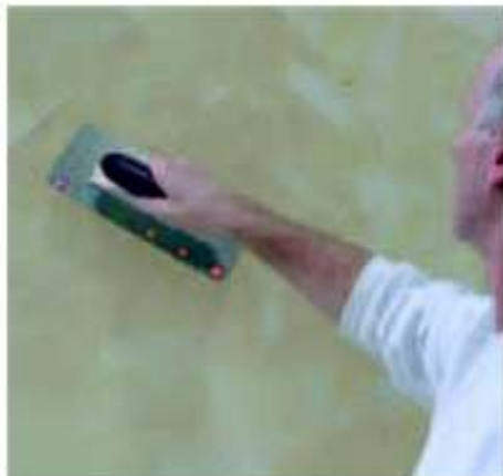
След нанасянето на материала по цялата повърхност на петна, започва смесването с шпаклара, като отнетия материал се почиства от инструмента периодично иначе надрасква повърхността
