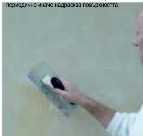
След нанасянето на материала по цялата повърхност на петна, започва смесването с шпаклара, като отнетия материал се почиства от инструмента периодично иначе надрасква повърхността
