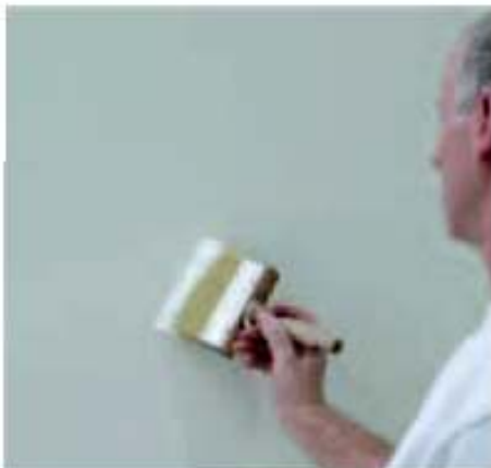
Полагане на предварителен грундиращ слой /Haftgrund/.
